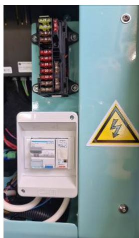
Figure 18, 19 – Alloggiamento impianto elettrico ausiliario e magnetotermico
