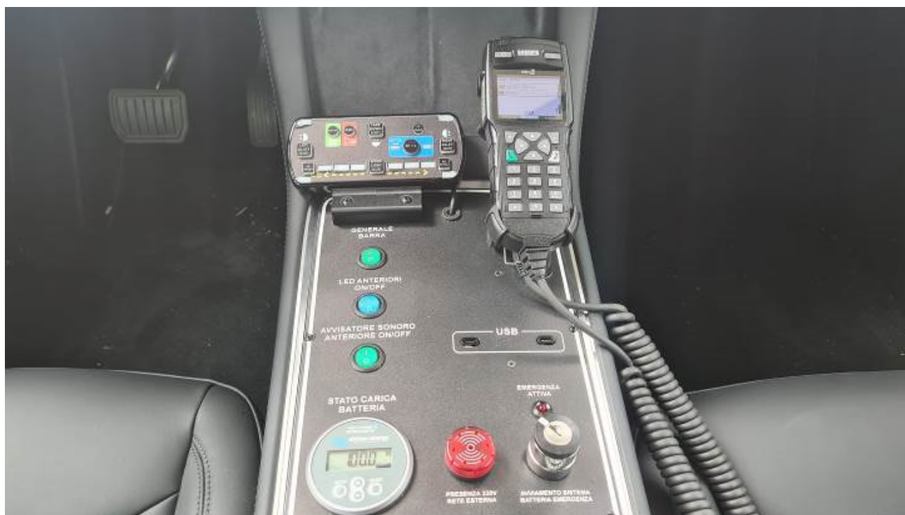
Figura 13 –Selettore a chiave per l'attivazione del bypass manuale
