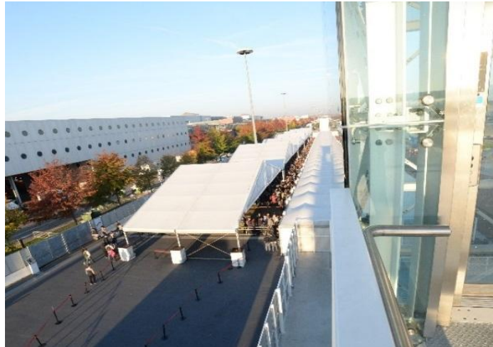
Figura 13 Tensostruttura di copertura area tornelli
